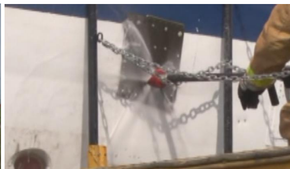
b) Media blasting (10:59:58)
